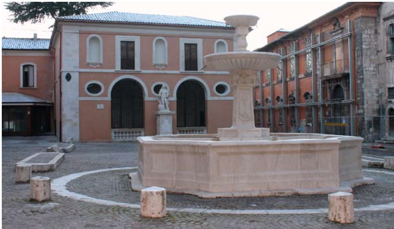
Il Palazzetto dei Nobili allo stato attuale dopo il restauro post-sisma
